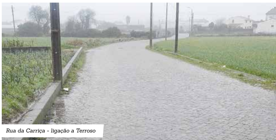
Infraestruturas e pavimentação Rua António Martins Torres
